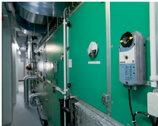
Erőteljes OpenAir zsalumozgatók HVAC alkalmazásokhoz 2 ... 35 Nm és 125 ... 250 N tartományban.
